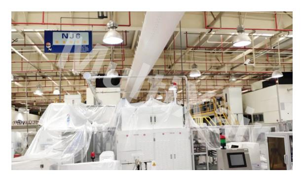
新建或改造医药库房用纤维织物纤维风管送风合适对于改造项目,由于多数风管使用年限比较久,通风管道经常会产生冷凝水、积尘,细菌滋生,这些都影响了药品存储的品质,更无法达到国家《药品经营质量管理规范》认证的标准。在家共同努力下,纤维织物纤维风管已在新建或改造的医药库房使用,送风精确,覆盖面积,使仓库内形成良好的气流组织,同时纤维织物纤维风管挂窗帘安装法,安装方便,渗透出风无凝露水产生[MX纤维风管有专业工程师现场查勘,方案设计,安装指导。
