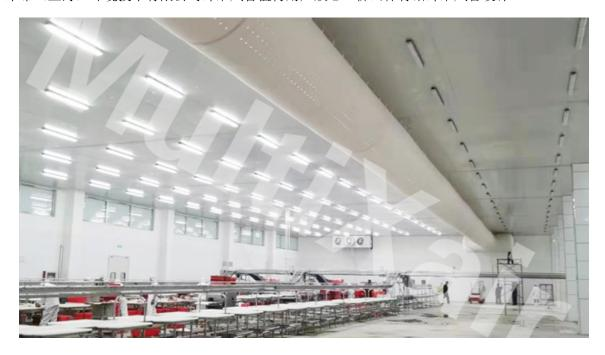
纤维风管在气流震动与噪音控制方面的优势。镀锌铁皮风管和无机玻璃钢风管的强度大,很容易满足风管的静压要求,但它们自身没有消声效果,像镀锌铁皮风管有时还会将输送设备发出的噪声传送到工作地点,因此需要加消声罩和消声弯头之类的消声配件。与镀锌铁皮风管和无机玻璃钢风管相比,纤维风管的强度相对要低,但是可以满足压强2000Pa的要求。纤维风管的外形是圆形,这是其他任何复合风管以及一般的铁皮风管都无法做到的,圆形风管是摩阻小的风道。另外,由于纤维风管是柔性的材料,因此消声效果也较好。佛山体育馆纤维风管设计米希(上海)环境技术有限公司为您提供纤维风管,期待为您服务!
